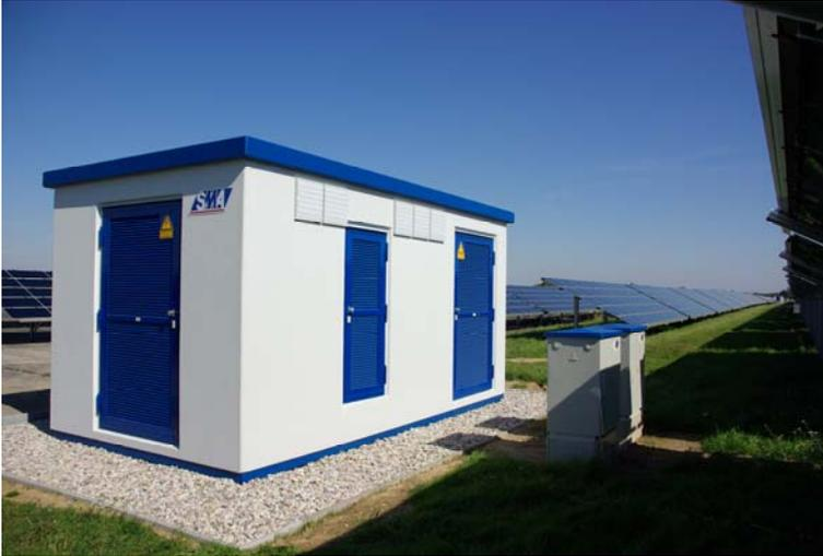
Abb. 6: Wechselrichterstation SC 1000 MV mit DC-Hauptverteilern
